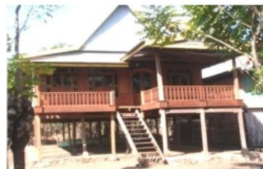
Gambar 4. Bentuk rumah yang masih belum melakukan pengembangan area kolong rumah
